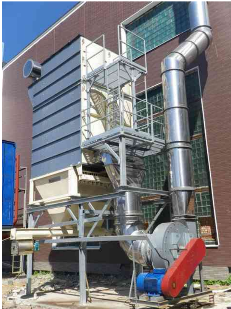
«Невский завод», аспирация индукционной печи.
