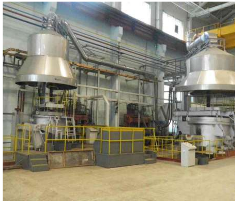
«Невский завод», аспирация индукционной печи.
