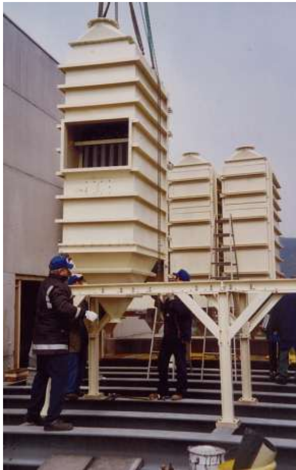
Корпус усиливается ребрами жесткости. Выдерживаемое давление – до 0,4 бар.
